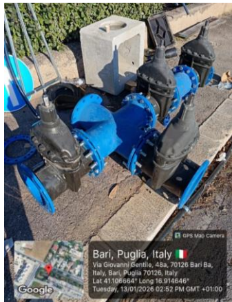
preassemblaggio nodo a 4 vie DN250
