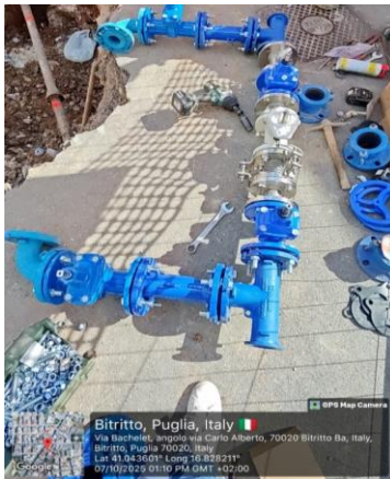
preassemblaggio circuito DN100 postazione di misura portata
