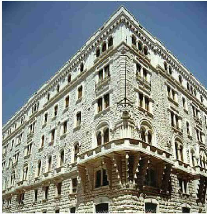
Il luogo Nella foto la sede dell'Acquedotto Pugliese a Bari
