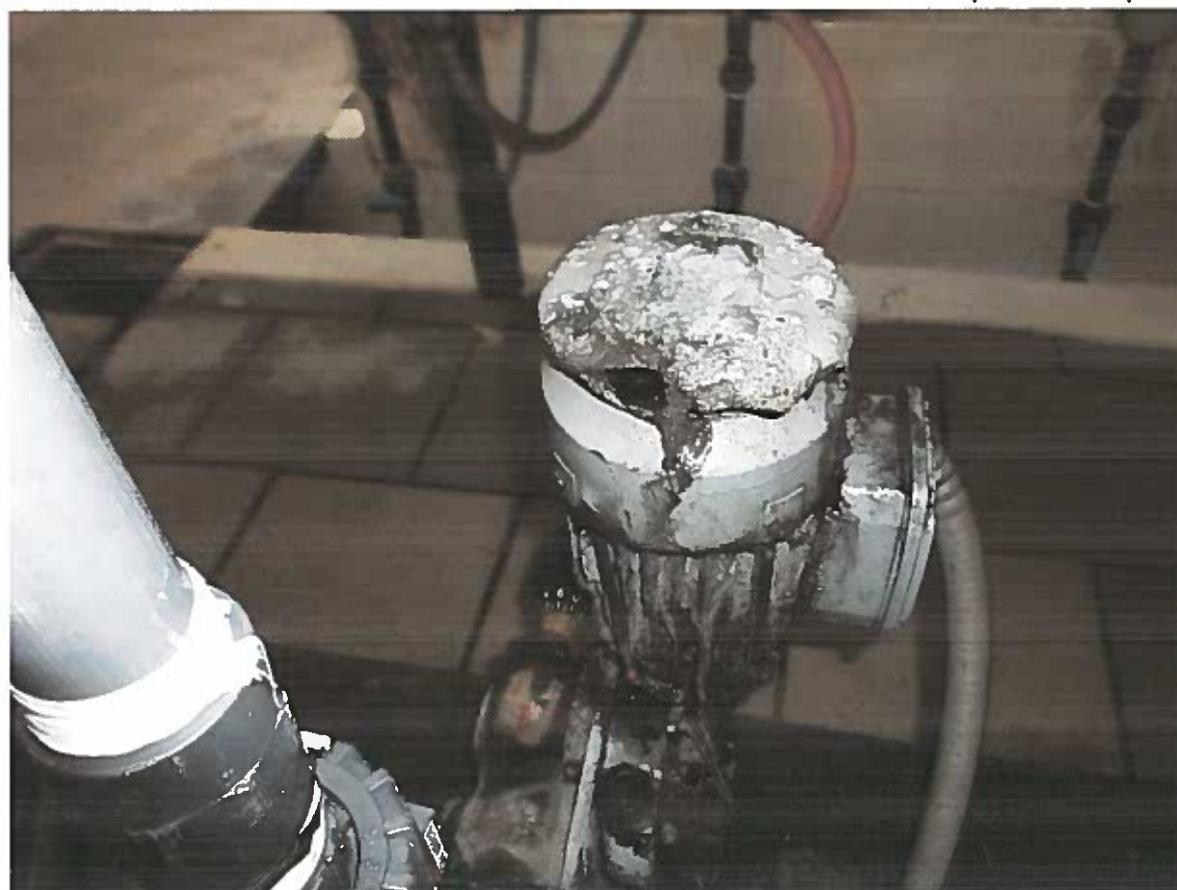
FOTO N. 5 - ELETTROPOMPA TIPO OGGETTO DI DANNEGGIAMENTO (09.09.2018)
