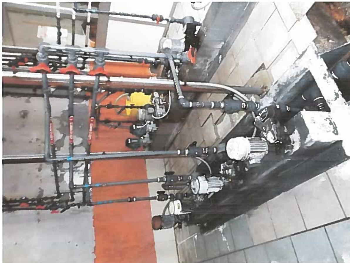
FOTO N. 3 - MANICOTTO LINEA ACIDO CLORIDRICO OGGETTO DI ROTTURA (09.09.2018)
