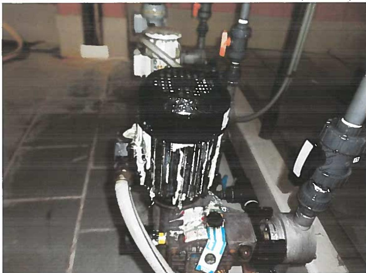
FOTO N. 6 - ELETTROPOMPA TIPO OGGETTO DI DANNEGGIAMENTO (09.09.2018)
