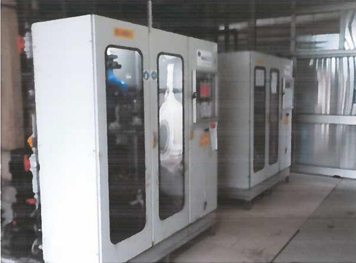
FOTO N. 14 - PARTICOLARE INVERTER GENERATORI BLOSSIDO DI CLORO A PURATE (09.09.2018)
