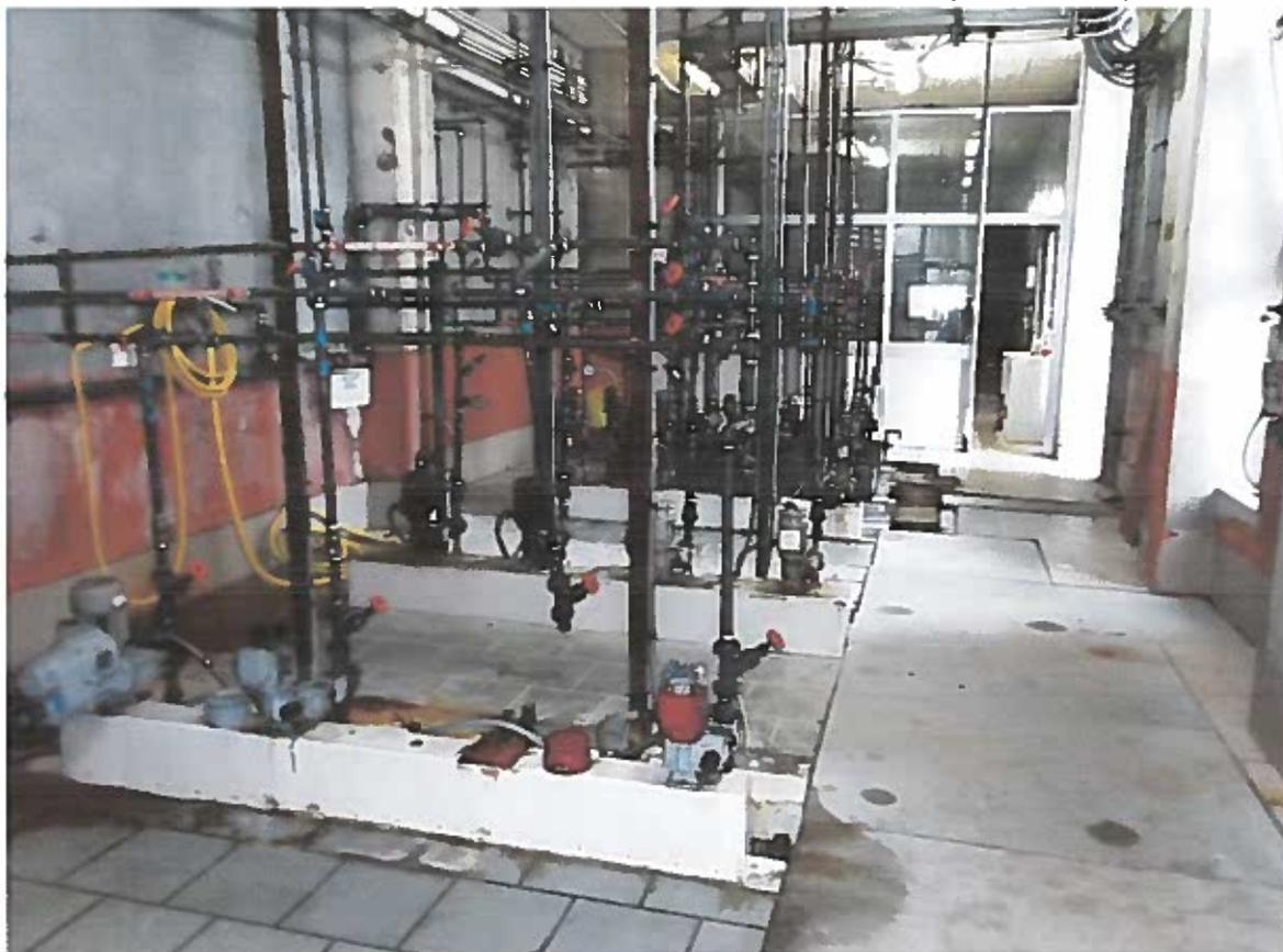
**FOTO N. 2 - BATTERIA ELETTROPOMPE DOSAGGIO REAGENTI CHIMICI (09.09.2018)**
