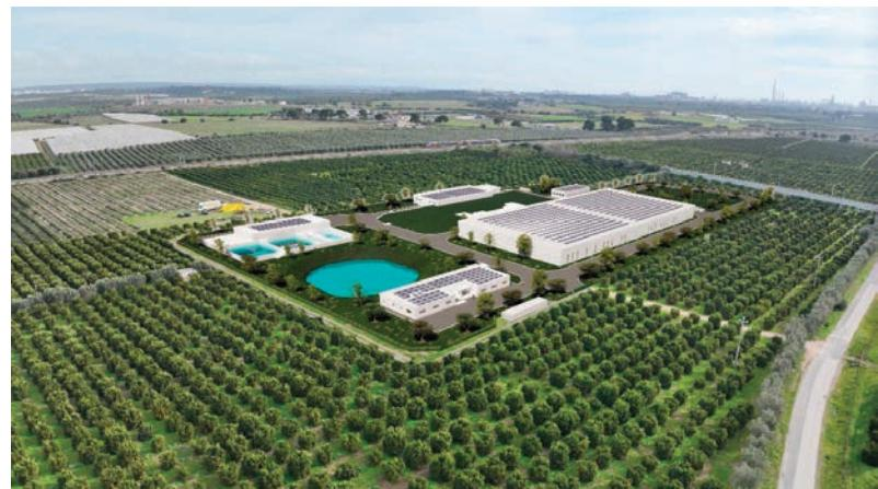
**L'impianto sorgerà su un terreno lungo la Provinciale 38, distante circa 1 chilometro dal corso del Tara. Da qui si dirameranno due condotte interrate: una di 14 chilometri, fra cui 5 da realizzare con innovative tecnologie no-dig, per portare acqua potabilizzata al grande serbatoio di Taranto, nodo cruciale della rete idrica da 24mila km di AQP; l'altra di 4,5 km per rilasciare nell'area del molo polisettoriale l'acqua residuale**
