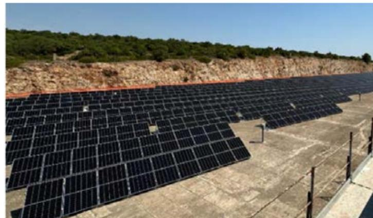
**c. Impianto di potabilizzazione del Sinni:** un ulteriore passo avanti nella transizione energetica di AQP è rappresentato dall'avvio dei lavori per la realizzazione di un impianto fotovoltaico da 423 kW sul lastrico solare del serbatoio di accumulo presso l'impianto di potabilizzazione del Sinni. Anche questo impianto sarà destinato a supportare il fabbisogno energetico dell'impianto di potabilizzazione, contribuendo alla riduzione del prelievo di energia dalla rete.
