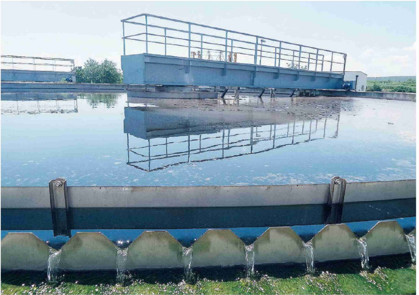
ACQUEDOTTO PUGLIESE Il depuratore di Gallipoli (Le), uno dei più importanti impianti per il trattamento in Puglia
