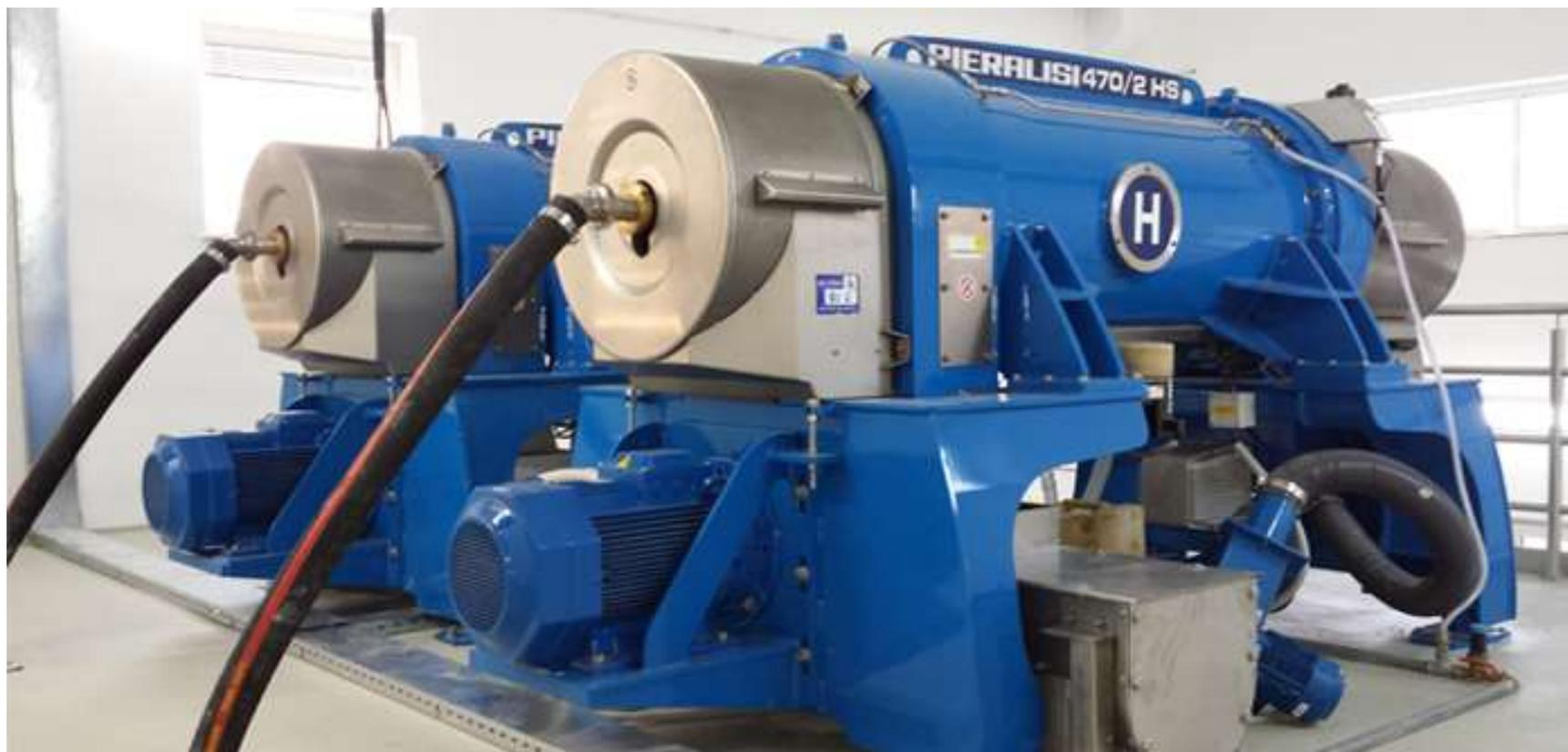
All'uscita della centrifuga il fango viene caricato su di un camion e, pur appearing solido, contiene ancora molta acqua: 75 – 80%
