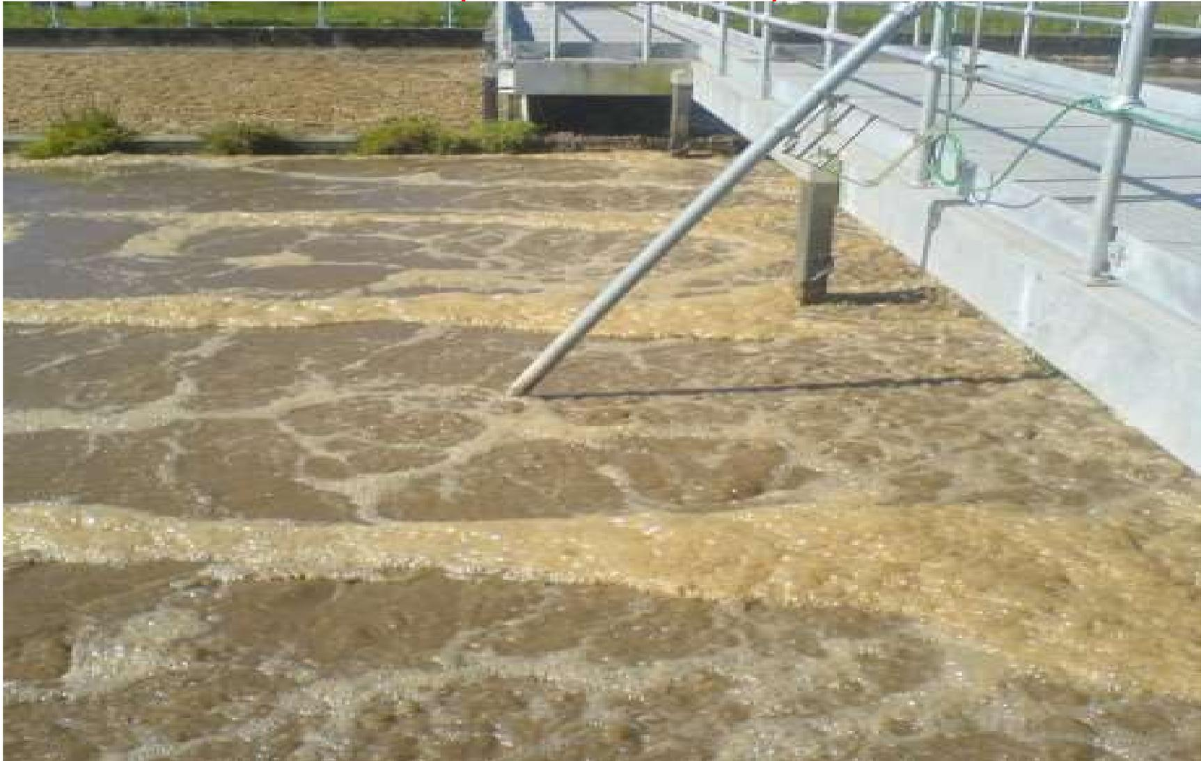
Per vivere i batteri che depurano hanno bisogno di ossigeno. Si introduce aria attraverso vari sistemi
