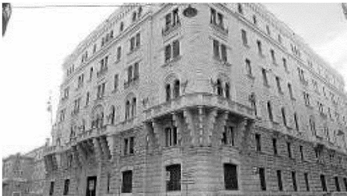
BARI La storica sede dell'Acquedotto Pugliese
