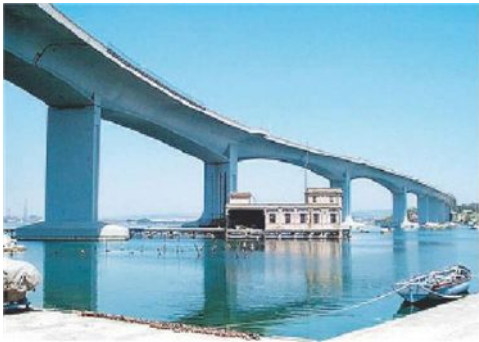
AQP Ripristinate le condotte sotto il ponte
