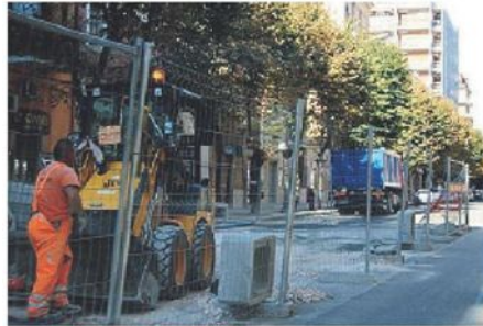
LAVORI IN CENTRO Un cantiere di Aqp
