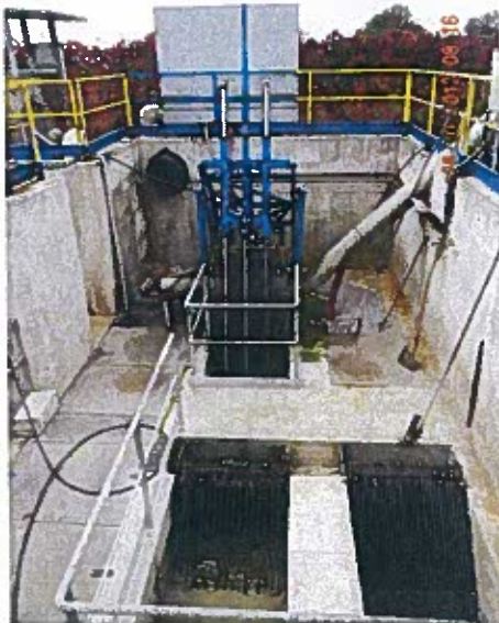
Figura 1: Stazione di grigliatura
