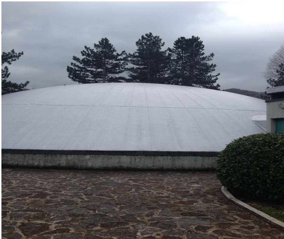
Foto_Copertura sorgente Pollentina_Cassano Irpino (AV)
