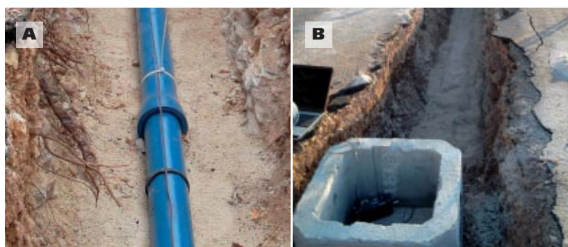
Fig. 4: PREDISPOSIZIONE DI S.I.M.P.Le. SU UNA NUOVA CONDOTTA IDRICA: A) PARTICOLARE DELL'INSTALLAZIONE DELL'ELEMENTO SENSIBILE, B) FASE DI RINTERRO DELL'ELEMENTO SENSIBILE E PREDISPOSIZIONE DEL POZZETTO DI ALLOGGIAMENTO CON L'ELEMENTO DI CONNESSIONE
