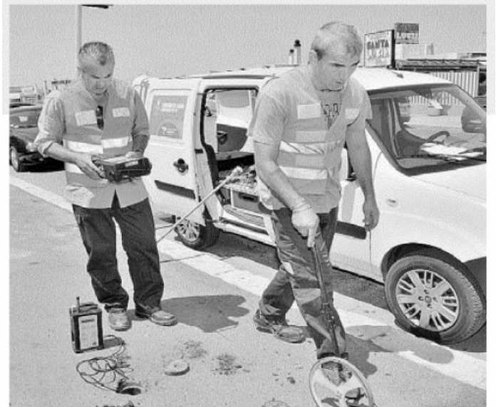
UNA RETE IMMENSA Sotto, uno degli schemi di controllo di Aqp. Qui sopra, al lavoro per individuare guasti e perdite di rete
