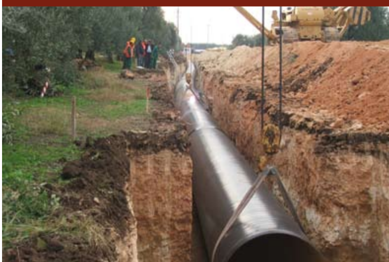
Lavori per la costruzione dell'acquedotto del Locone
